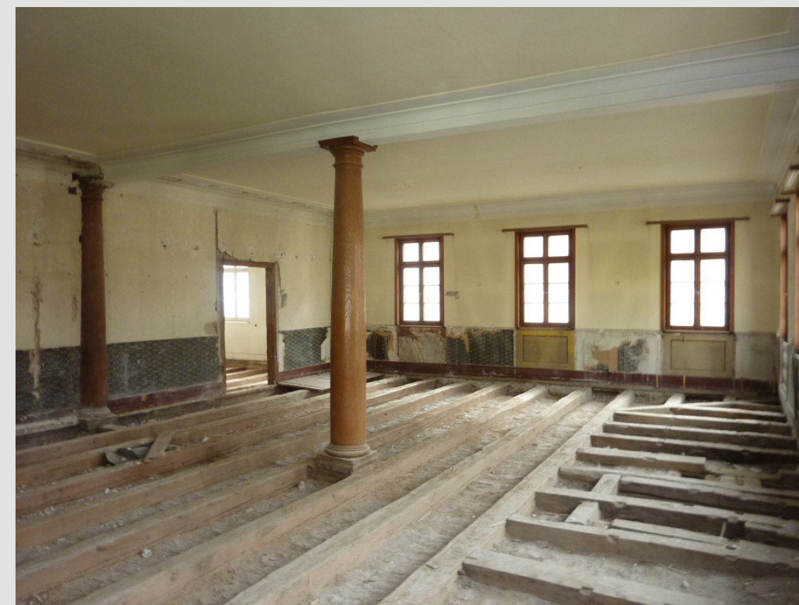
Sitzungssaal während der Bauarbeiten
