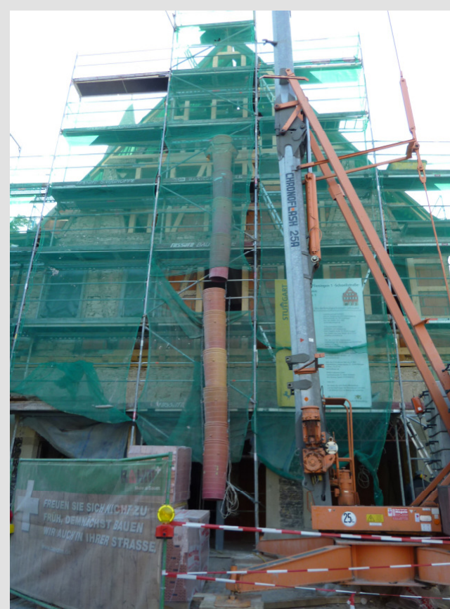
während der Sanierung
