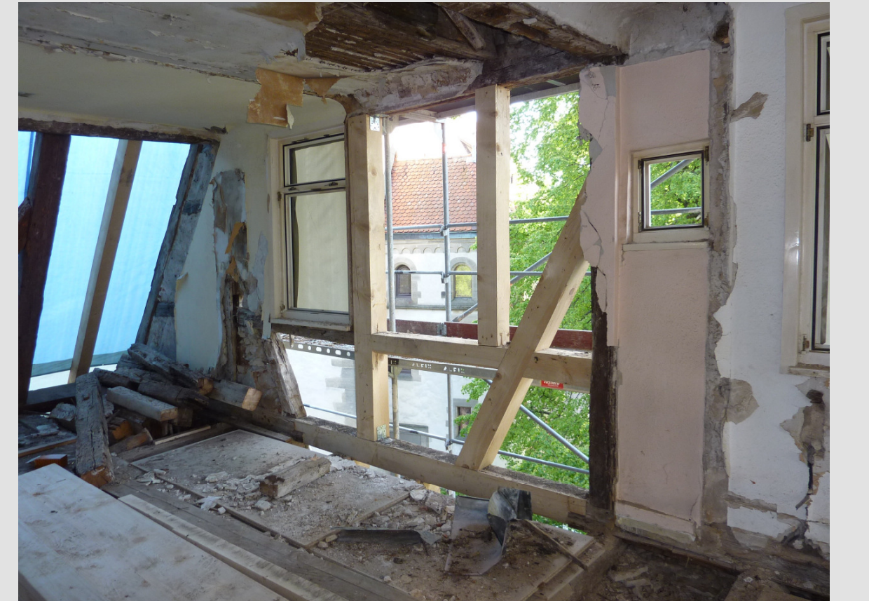
Sanierungsarbeiten am Tragwerk
