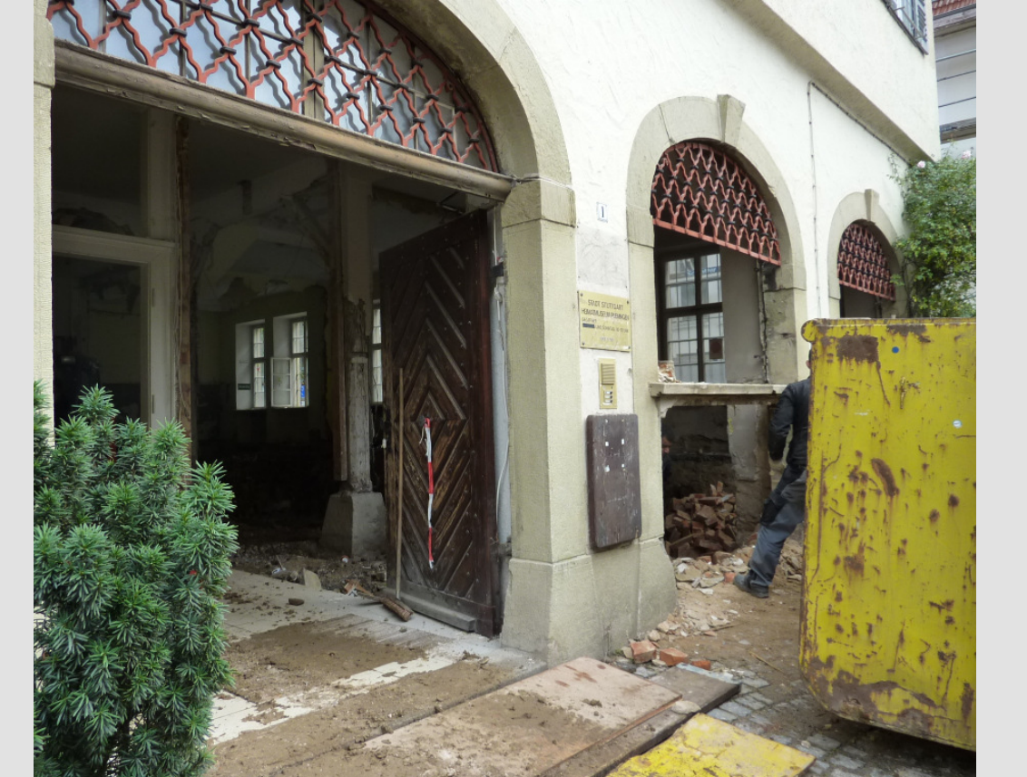
Eingang zum Rathaus - Sanierungsphase
