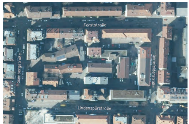
Blockrandbauweise mit gründerzeitlichen Bezügen hinsichtlich der Gliederung jedoch geringer Anteil an gründerzeitlicher Bausubstanz
