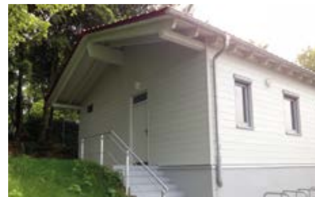
Holzhaus vor (oben) und nach (mitte und unten) dem Umbau
