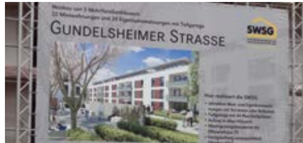
Bauschild der SWSG – Neubeu von Eigentumswohnungen und frei finanzierten Mietwohnungen
