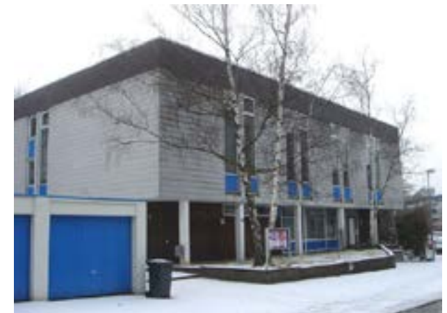
Vor der Modernisierung im Januar 2006
