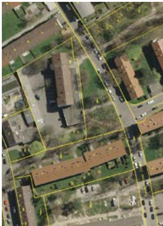
Gundelsheimer Straße 51 vor dem Rückbau, Luftaufnahme Stadtmessungsamt
