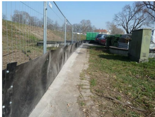
Abbildung 3: Beispielskizze eines Reptilienschutzzaunes (rechtes Bild). Auf dem linken Bild wurde der Zaun in einen Schlitz in der Gehwegdecke eingelassen.
